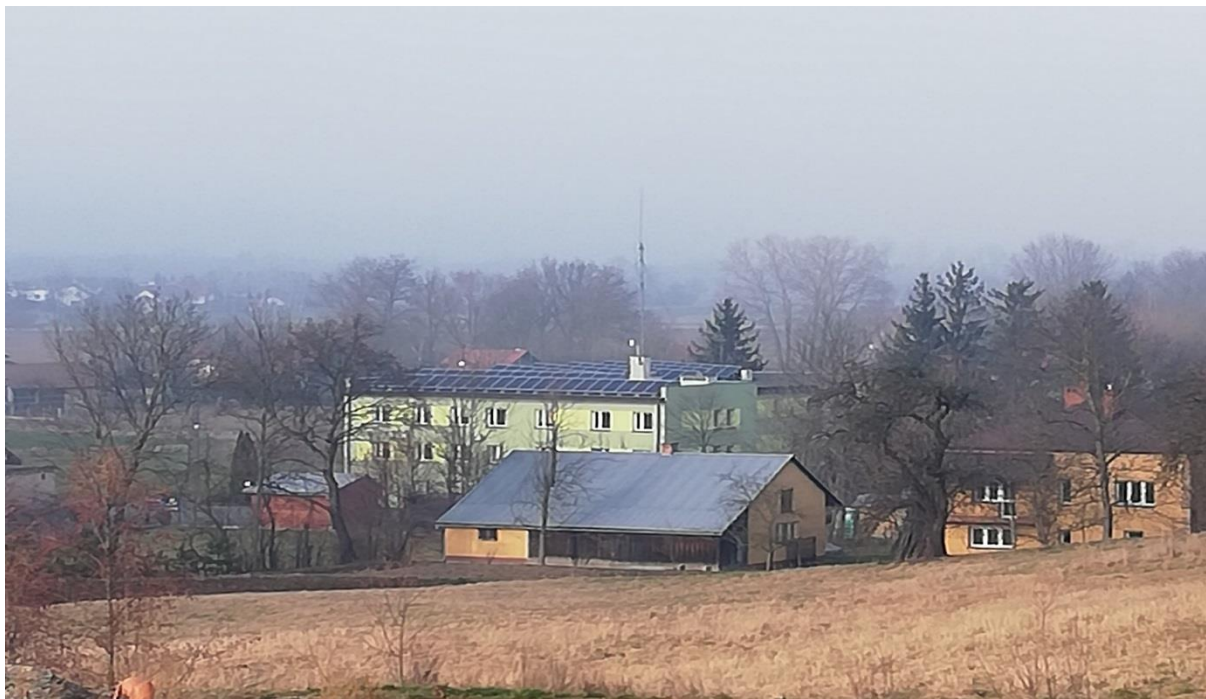
Zestaw instalacji fotowoltaicznej składający się z 79 szt. paneli fotowoltaicznych o mocy 22,00 kWp na budynku Urzędu Gminy w Rokietnicy – wartość całkowita brutto 126.237,36 zł. brutto.
